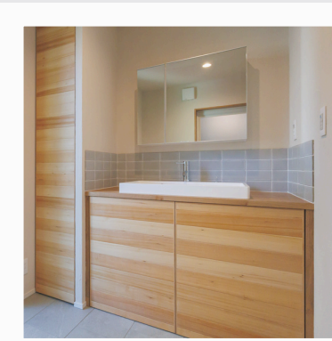
〈造作カウンター〉 ナラ集成材・ヘムパネリング
