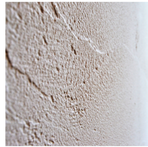
〈壁・天井〉 ECOWALL・なできり仕上げ
