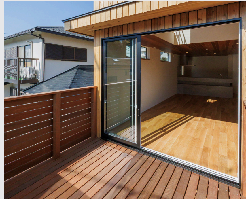
〈サッシ〉 TWトリプルガラス Arガス入 室内側：ホワイト 室外側：ダスクグレー
